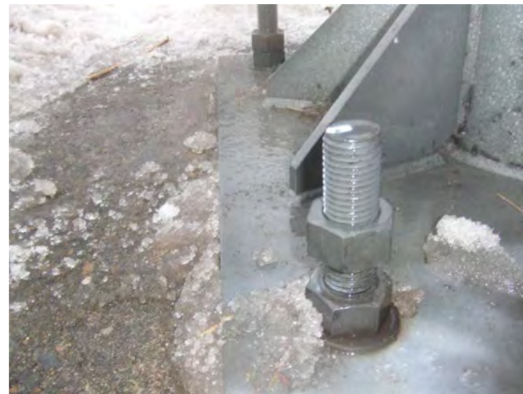
ボルトの緩み (施工不良)
