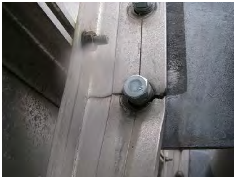
き裂損傷 (車両衝突)
