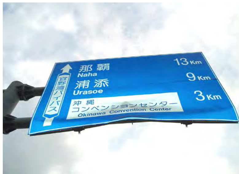
異常変形 (車両衝突)
