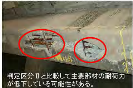
判定区分Ⅲ(主桁の断面欠損)
