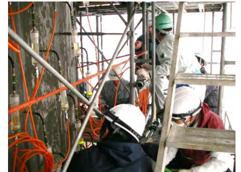
亜硝酸リチウム内部圧入工法
